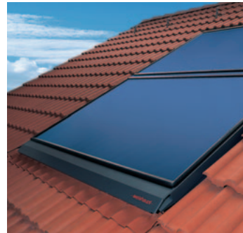
V strešni konstrukciji
