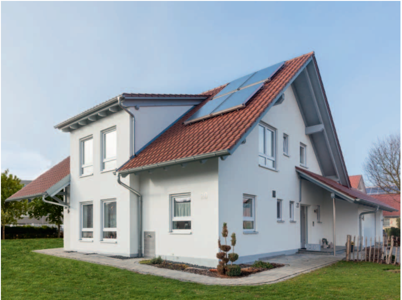
Kollektoranlage zur kombinierten Trinkwassererwärmung und Heizungsunterstützung
