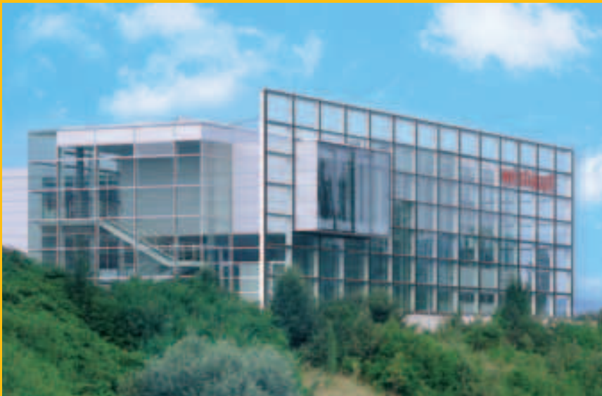
Schulungs- und Verwaltungsgebäude in Geroldswil (ZH)
